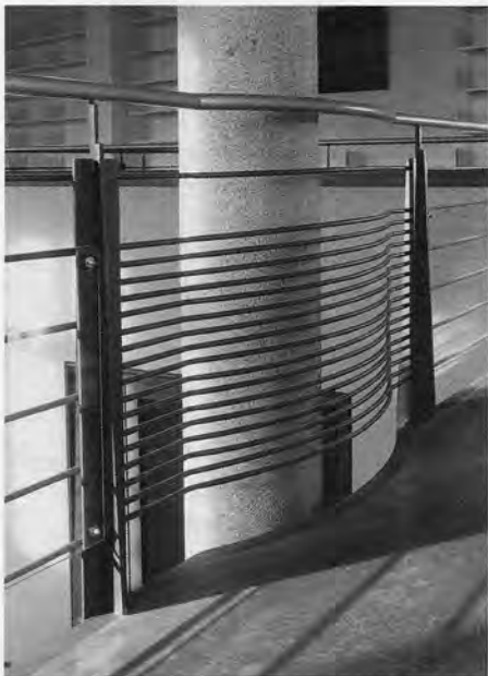
Abb. 2: Renovierung und Umbau des Mantelsaales der Stadtbibliothek Lübeck, 1995. Architekten: Mai, Zill, Kuhsen, Lübeck.
