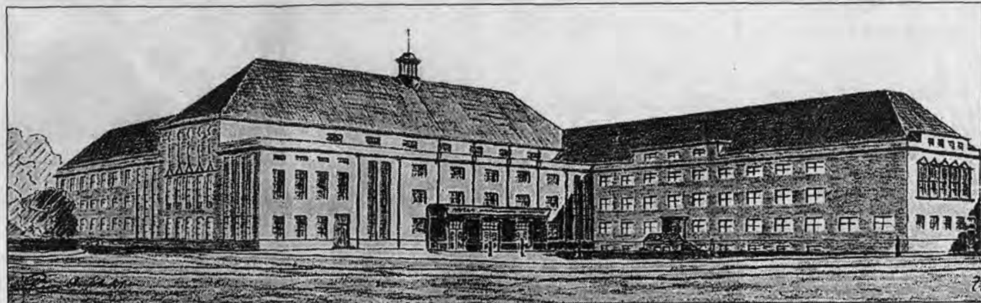
Das Deutsche Haus: Im Entwurf (oben) und in der Ausführung (unten). Ziegler hätte gerne ein Walmdach gehabt. Doch die Regierung in Berlin genehmigte diese Pläne nicht. Das Flachdach entstand, ein Turm verbindet optisch Haupt- und Nebentrakt.
